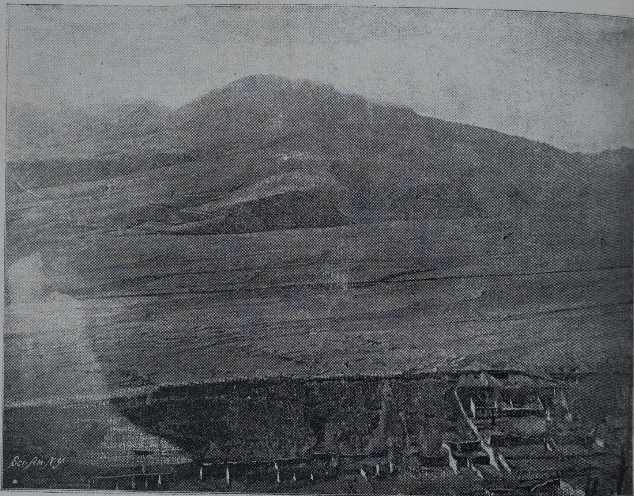
PARTE NORTE DE ST. PIERRE, CUBIERTA POR UNA INUNDACIÓN DE FANGO, QUE POR TÉRMINO MEDIO ALCANZABA 200 PIES DE ALTURA.
