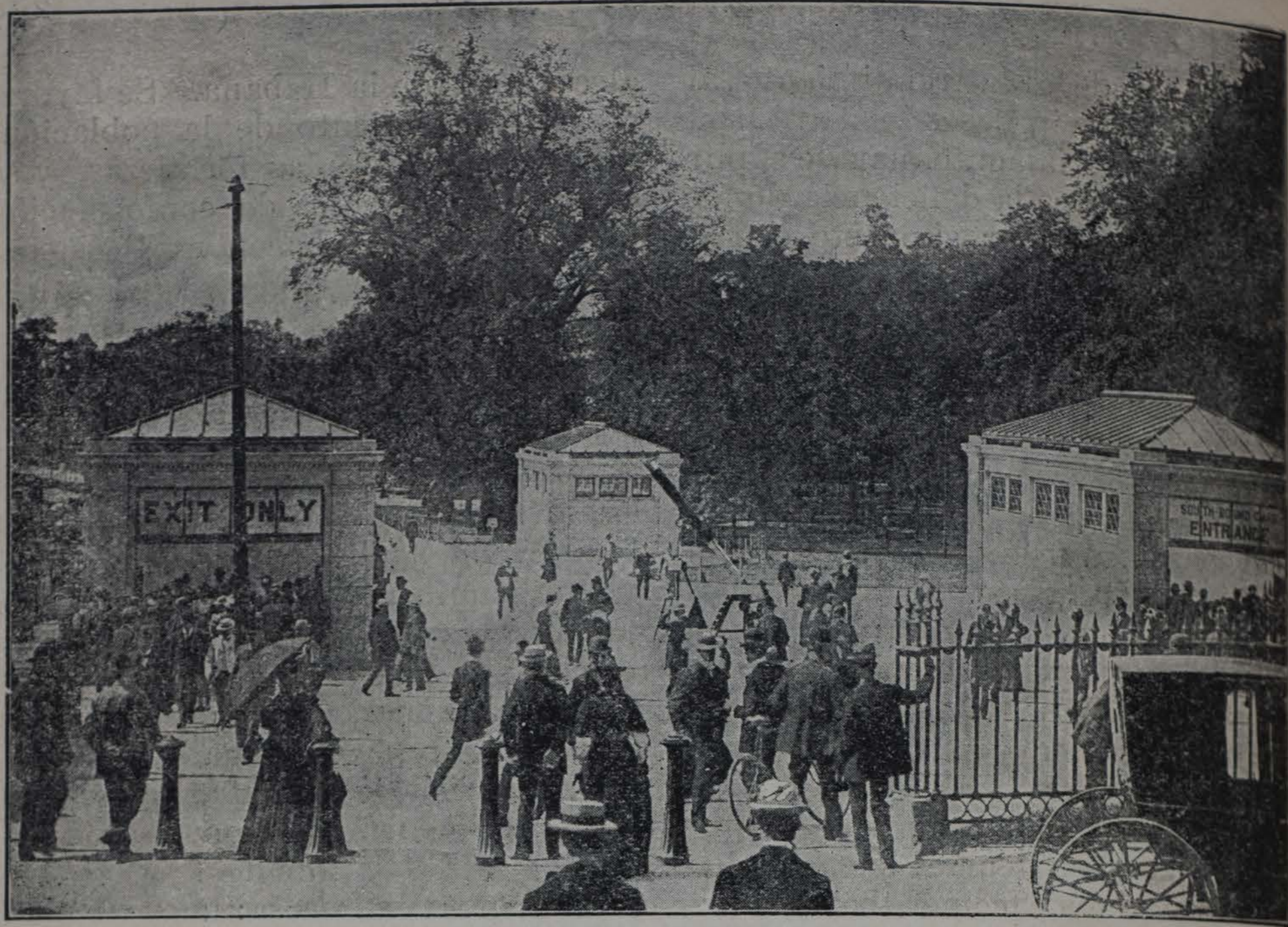
ENTRADA AL FERROCARRIL SUBTERRÁNEO DE BOSTON. ESTADOS UNIDOS.
