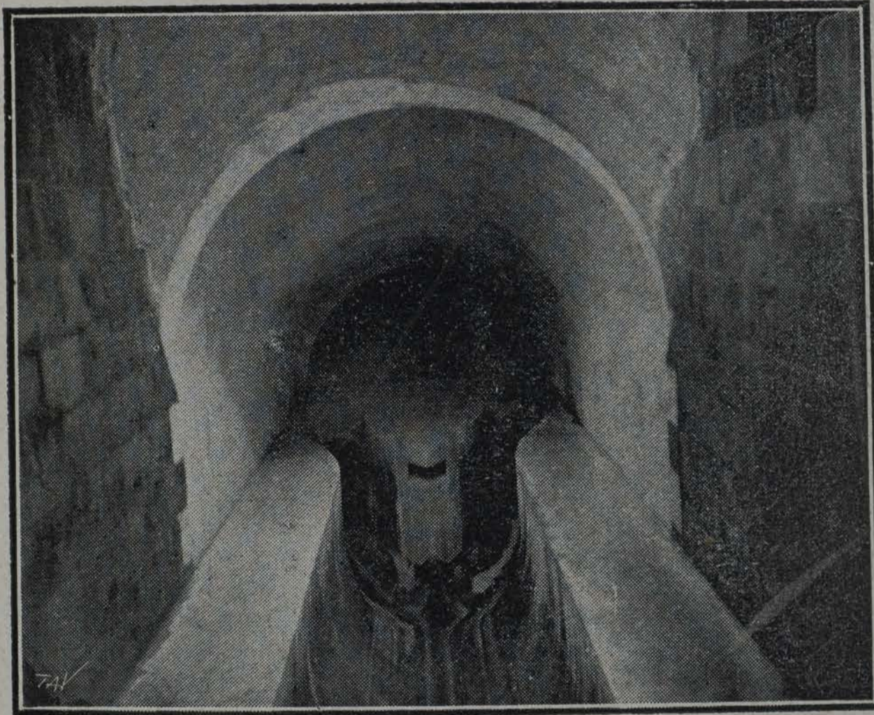
CÁMARA DE DESCARGA. SALIDA DE LOS SIFONES.
