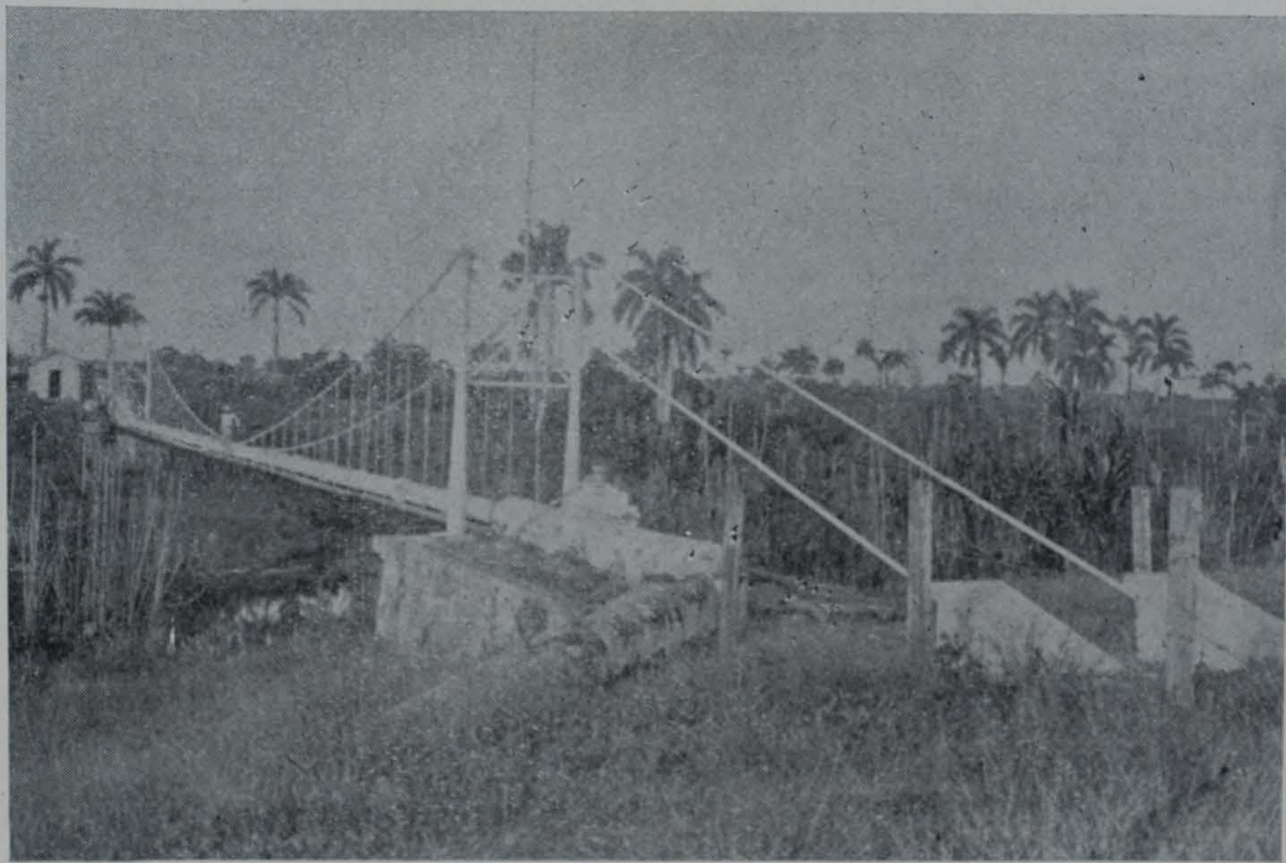
PUENTE COLGANTE DE ACERO SOBRE EL RÍO SAN AGUSTÍN PARA CONDUCIR LA TUBERÍA PRINCIPAL Á LA CIUDAD.
