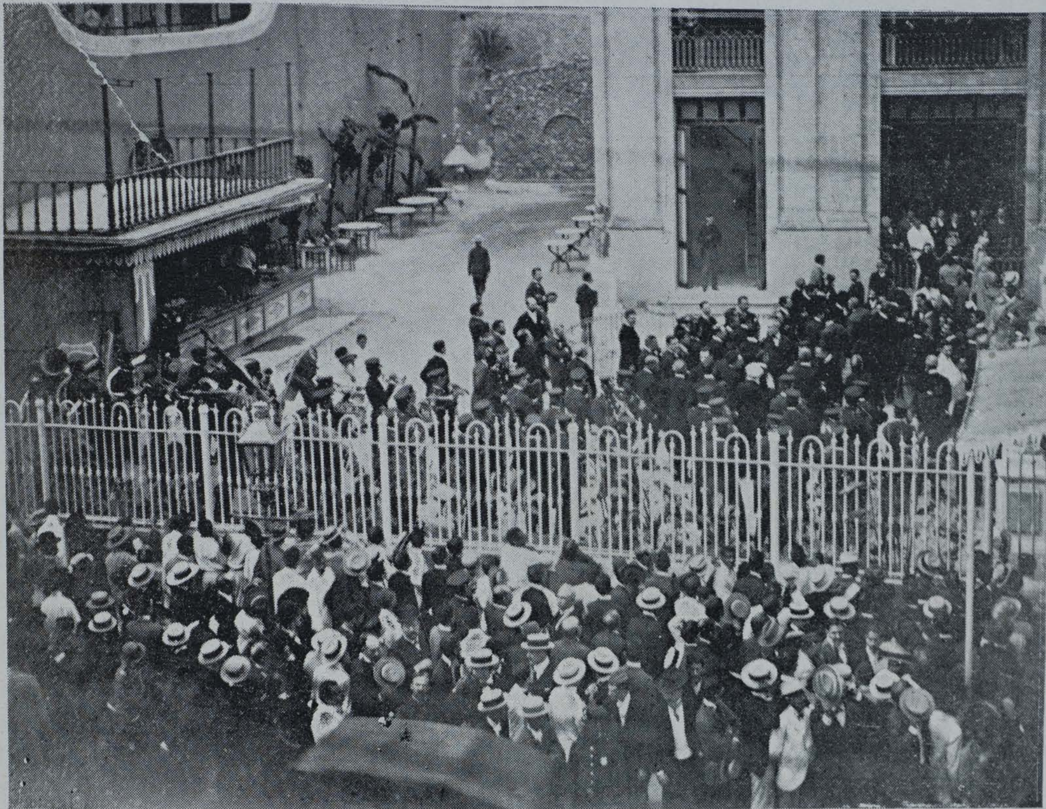
VISTA EXTERIOR DEL PALACIO DE LA CONVENCION.
