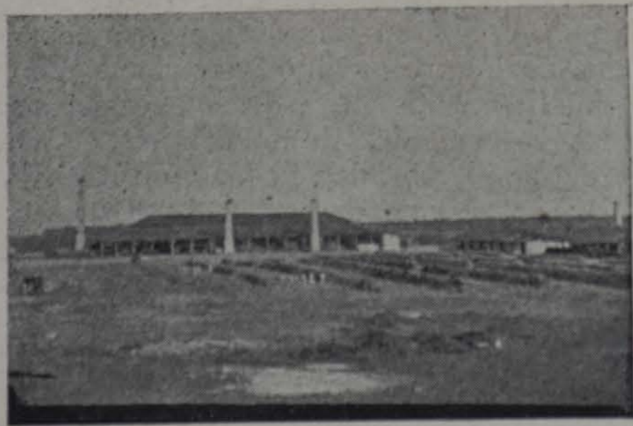
Casa de Calderas de un ingenio.—Cuba.
