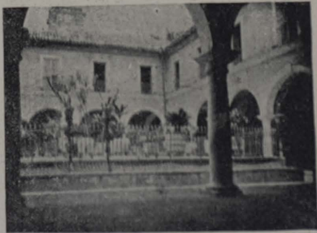
Patio del Colegio de Belen.—Habana.
