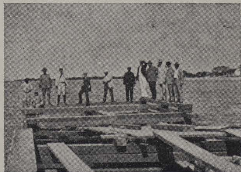
Obras en el muelle de la Playa de Marianao. Recuerdos de la guerra.
