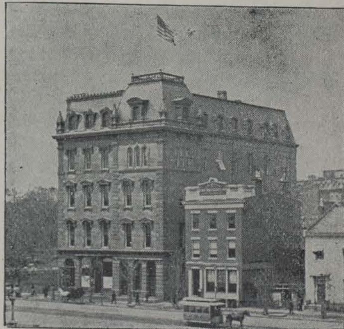
Edificio del Departamento de Justicia en Washington.
