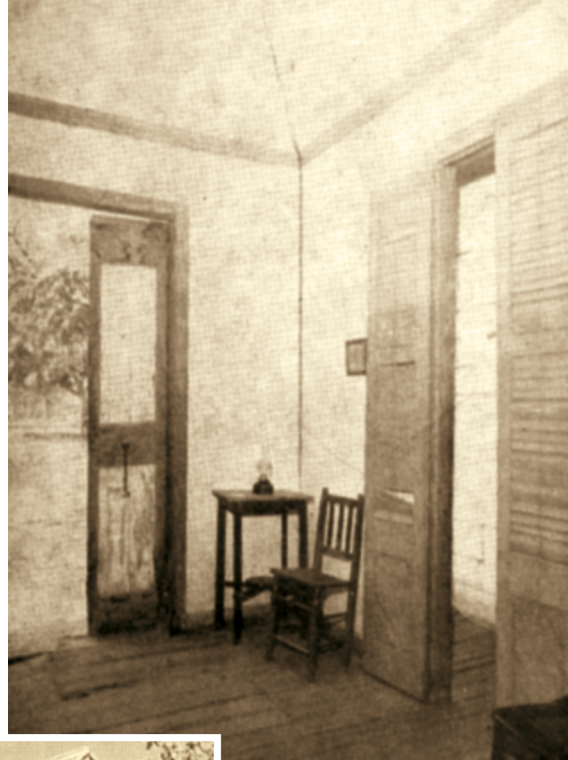
Detalle interior de la humilde vivienda.
