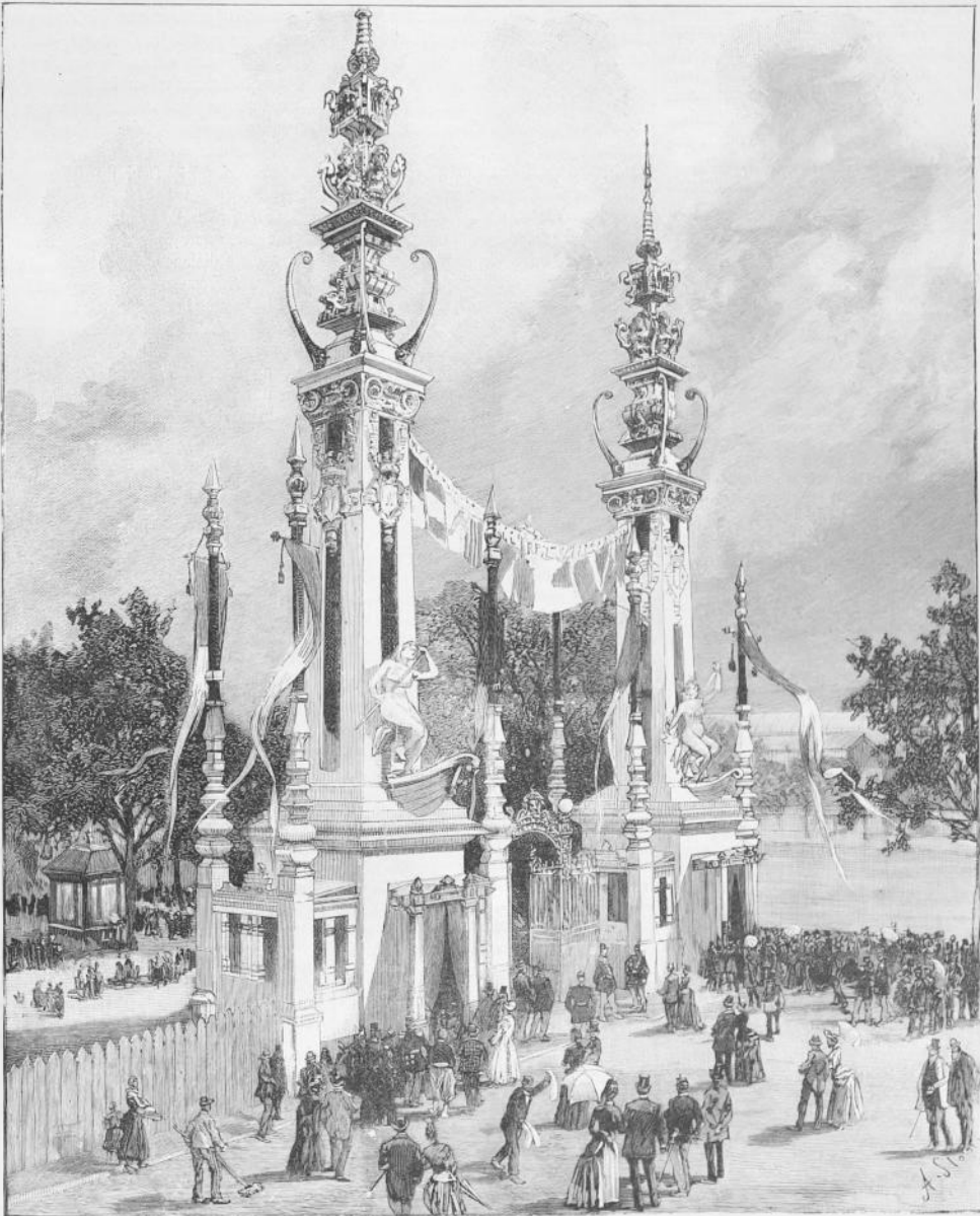
LA PORTE D'ENTRÉE DU QUAI D'ORSAY.
