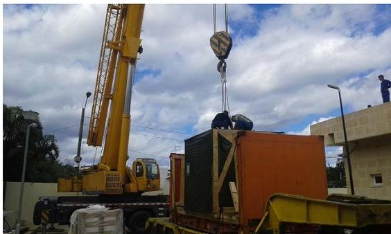
Se trasladó desde el puerto del Mariel hasta el Centro Especializado de Diagnóstico y Terapia el primer Ciclotrón de Cuba, el cual fue introducido en el bunker y colocado en sus puntos de apoyo según el proyecto del Ion Beam Applications SA, EURONEXT (IBA).
