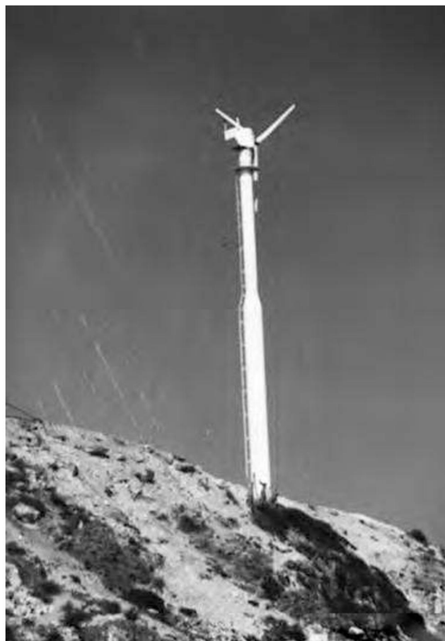
Fig. 10. El aerogenerador Tornado T7-10kW en Cabo Cruz, Granma.
