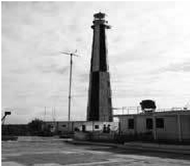
Fig. 4. Ejemplo de aplicación de un pequeño aerogenerador en una zona de seguridad en un faro.
