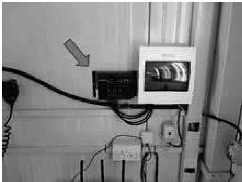
Fig.5. Regulador fotovoltaico conectado al sistema de comunicación.
