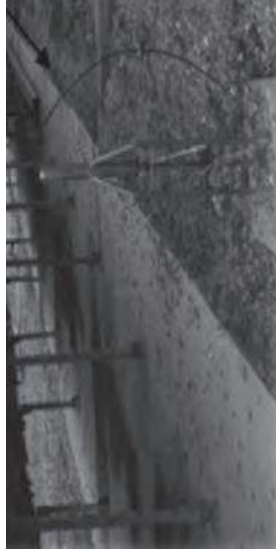
Fig. 1. Aterramiento inadecuado.
