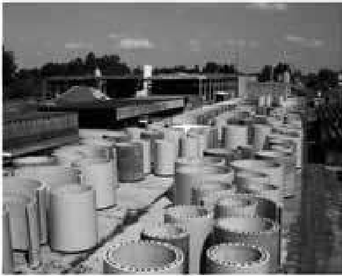
Fig. 3. Fabricación de torres de hormigón.
