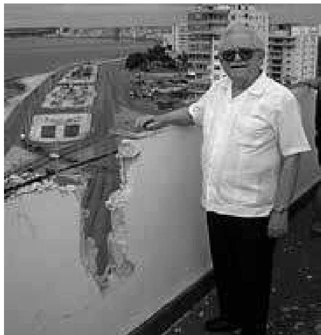
Fig. 1. Destrozo producido el 25 de junio de 2009 por un rayo en la azotea del edificio aludido en el texto, con la entrada a la bahía de La Habana al fondo y el autor captado junto al boquete.
