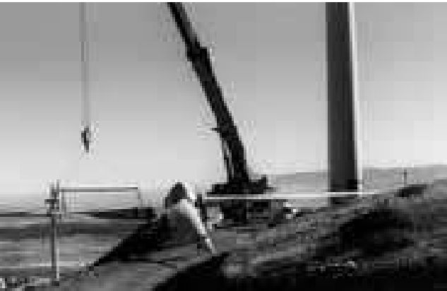
Fig. 6. Cambio de pala.
