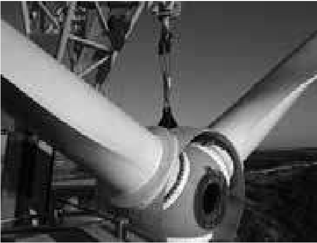
Fig. 5. Cambio de rotor.
