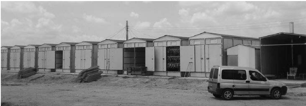
Fig. 4. Batería de cámaras.
