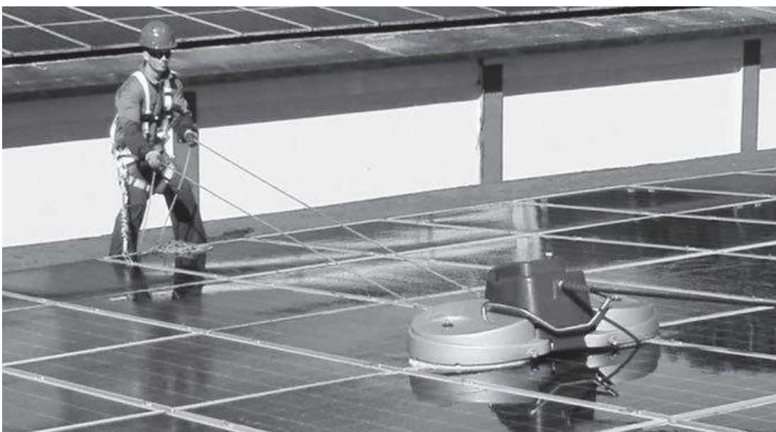
Fig. 1. Instalación de paneles de forma paralela a la cubierta con equipo de limpieza.
