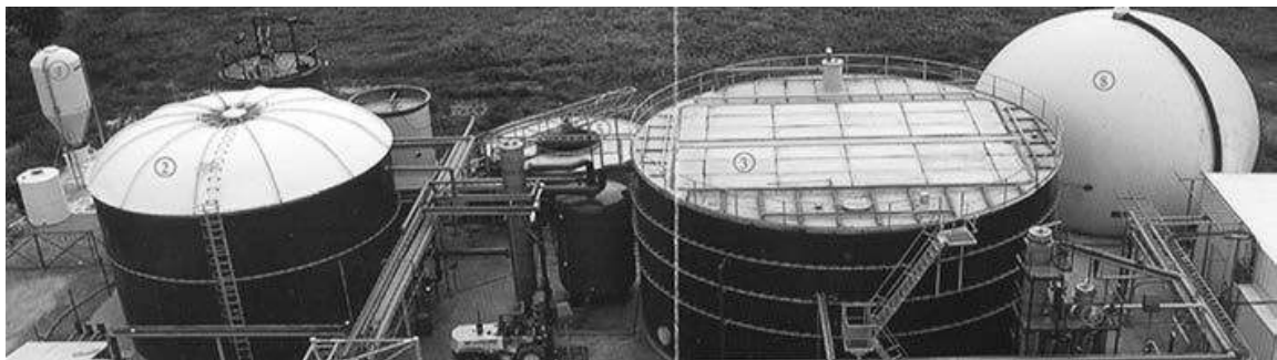
Fig. 2. Ejemplo de reactores UASB (del inglés Upflow Anaerobic Sludge Blanket , o reactor anaerobio de flujo ascendente con manto de lodos) propuestos.
