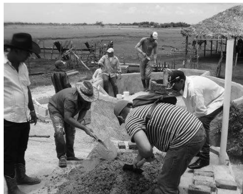
Fig. 2. Construcción del biodigestor.
