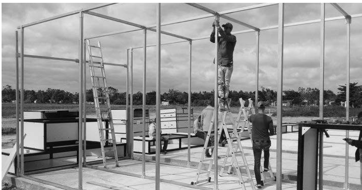
Fig. 1. Proceso de construcción.
