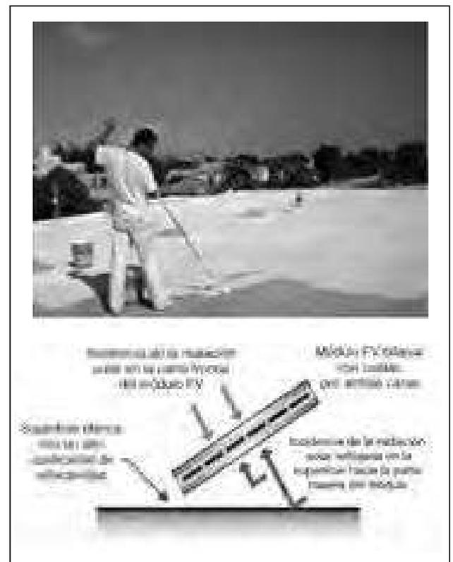
Fig. 10. Utilización de la radiación albedo.
