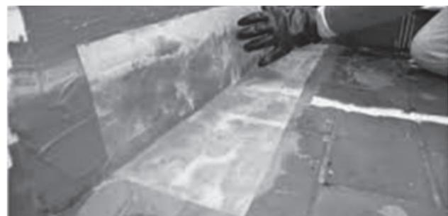
Fig. 3. Manta de fibra de vidrio aplicada en parches.
