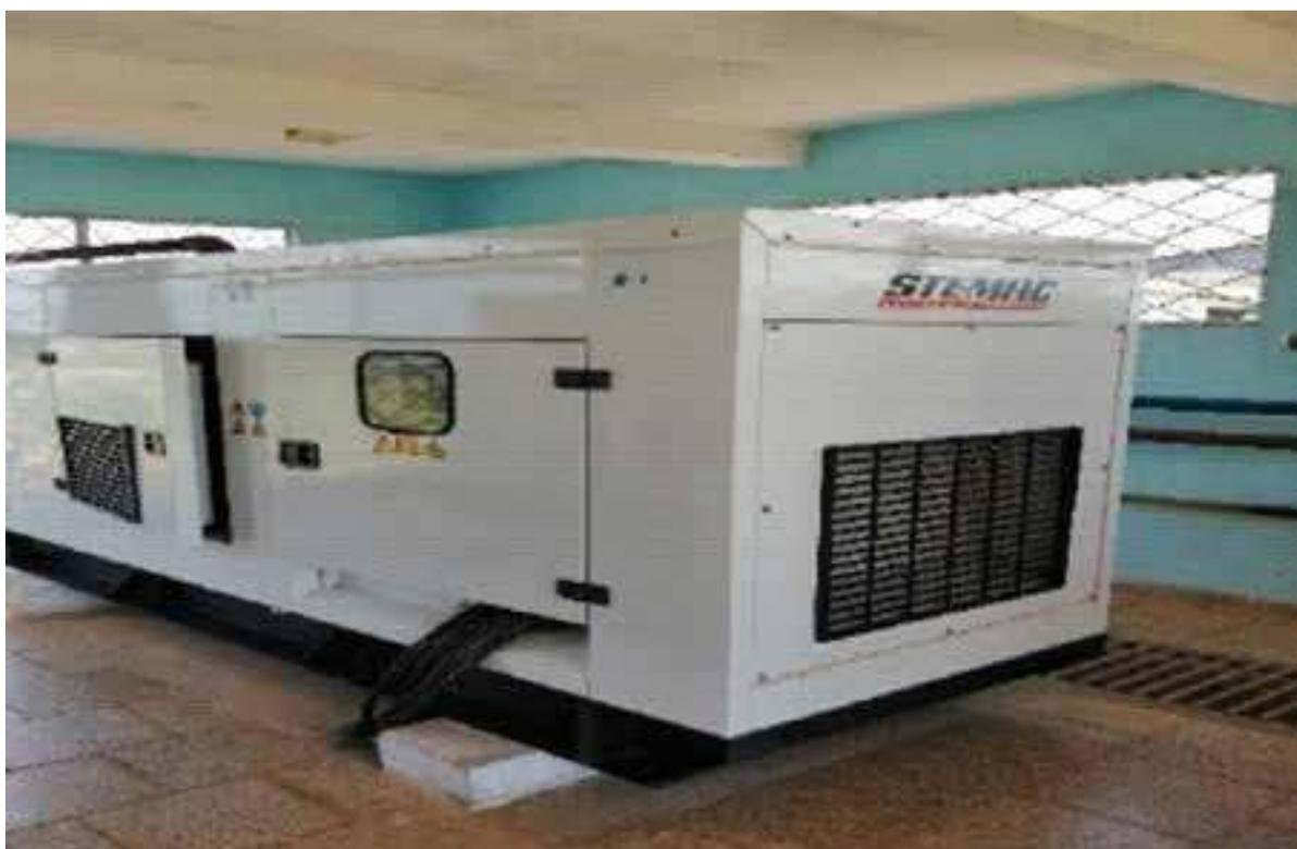
Fig. 9. Grupo electrógeno a biogás.
