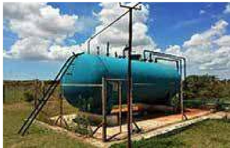
Fig. 3. Depósito del biogás.
