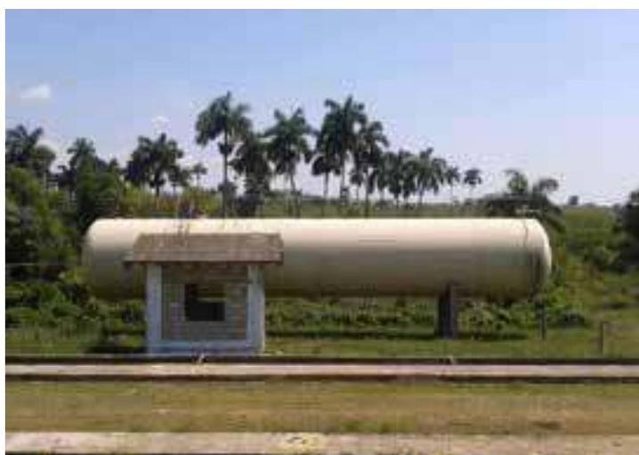
Fig. 2. Depósito del biogás.
