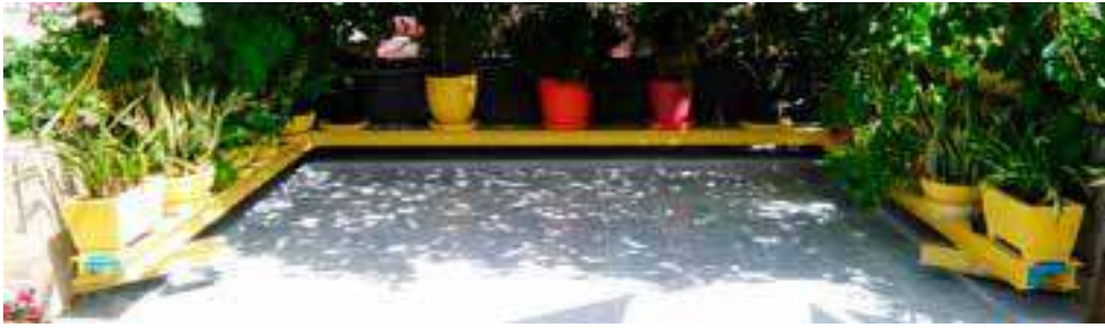
Fig. 7. Estructura de vigas de acero en una sección cubierta con uva, fuente: elaboración propia.
