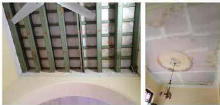
Figs. 5 y 6. Vista de la composición interior de la cubierta de la vivienda.
