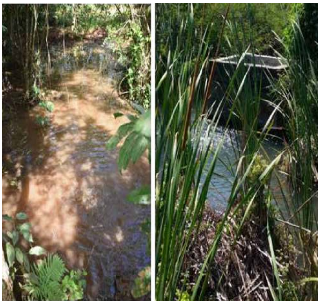
Fig. 2. Salideros y acometidas ilegales conectadas a elementos de la red.
