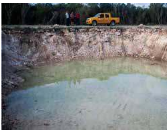
Ilustración 3 Construcción de la base de un Aerogenerador (Fuente: Cubahora).
