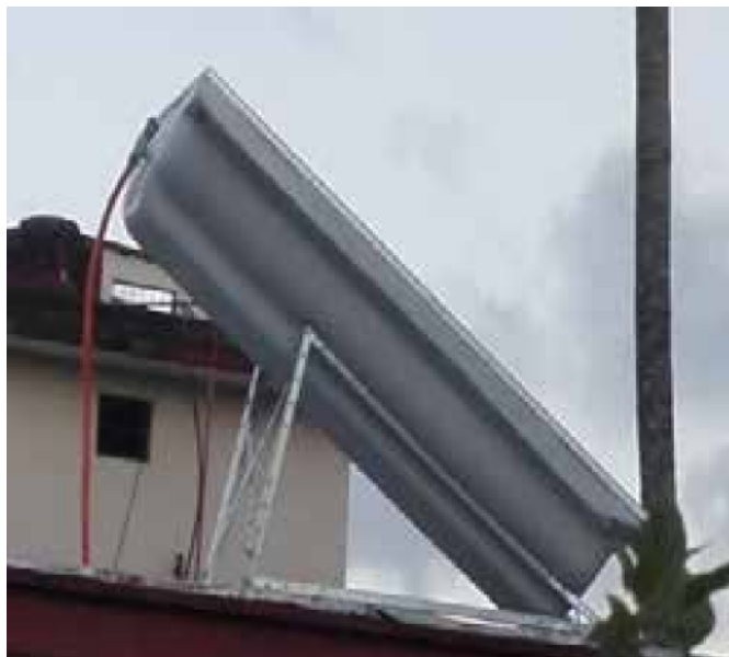
Fig. 2. Calentador solar instalado sobre bastidor ligero. Elaboración propia.
