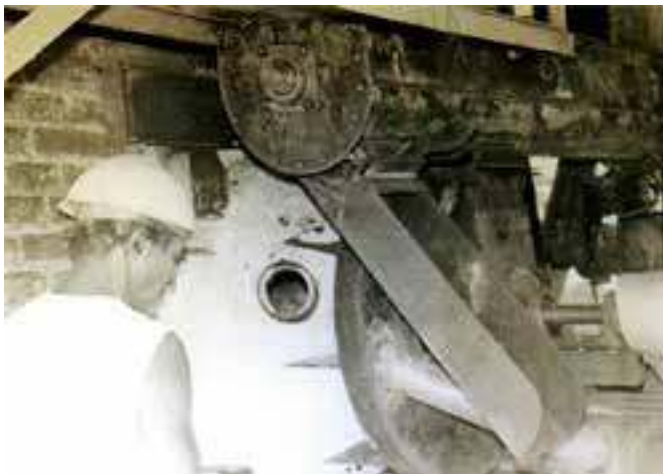
Fig. 4. Primer quemador rotatorio para meollo. Fábrica de tableros de bagazo de Cruces. (Fuente: [Rodríguez, 1988; Rodríguez 1995]).
