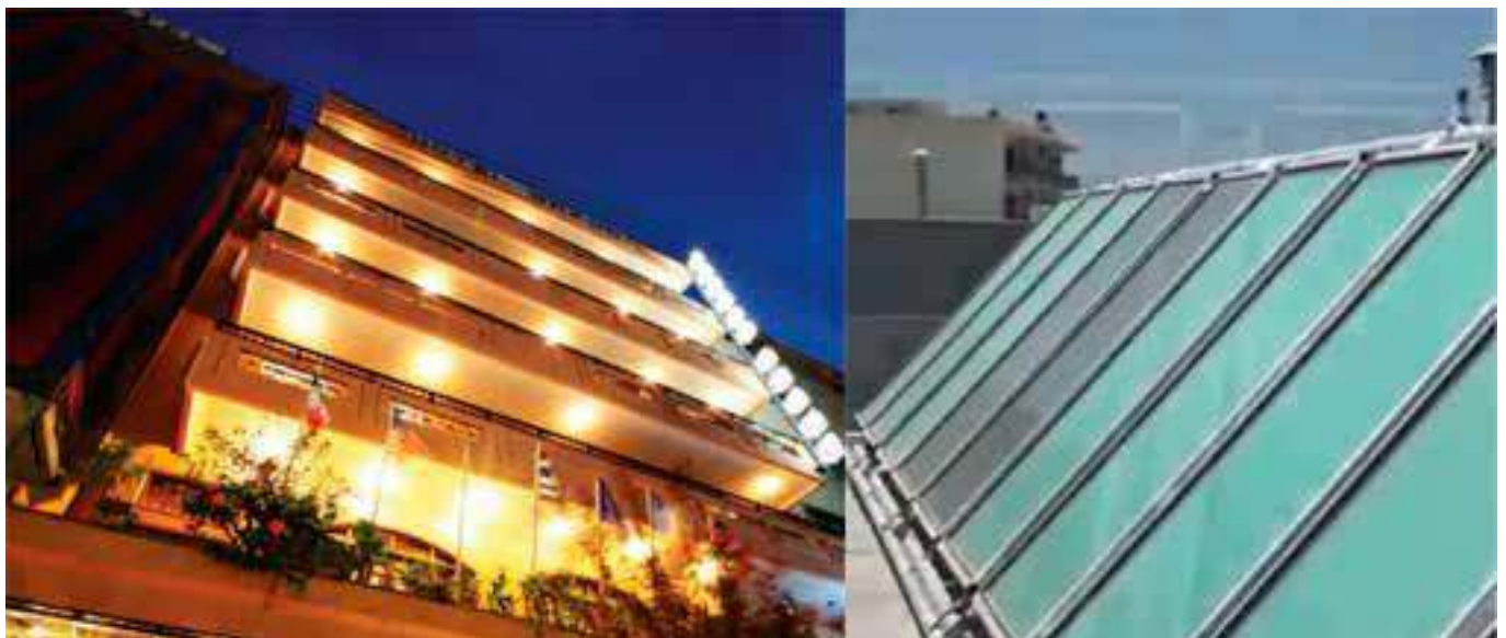
Fig. 3. Hotel Arkadi, Grecia. Hotel de ciudad con 64 habitaciones que cubre 50 % de su energía mediante FRE (solar fotovoltaica y térmica).
