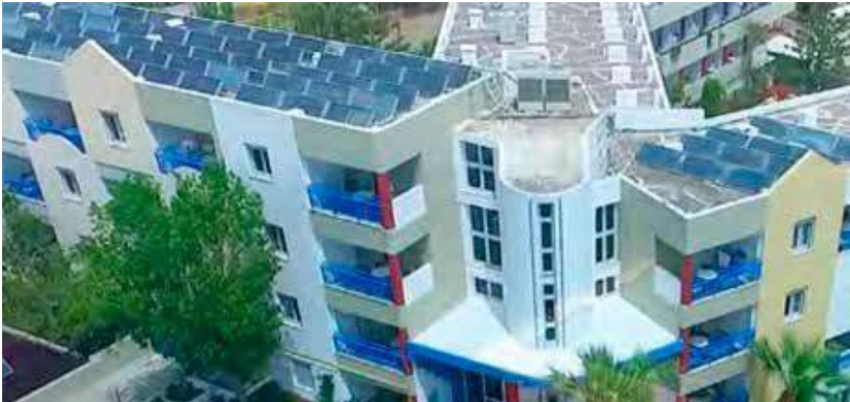
Fig. 4. Hotel Ibsicos Garden Blue Star, Grecia. Hotel de ciudad con 324 camas que cubre 50 % de su energía mediante FRE (solar fotovoltaica y térmica).
