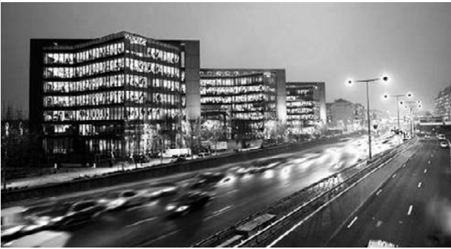
Fig. 1. Edificio de oficinas con certificación BREAM en Madrid [Bream, 2013].
