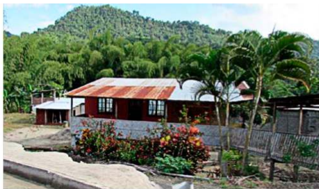
Fig. 9. Vivienda popular con cubierta de plancha acanalada de acero galvanizado en Portoviejo, provincia de Manabí, Ecuador.
