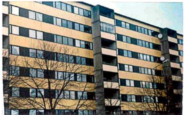
Fig. 3. Edificio de viviendas «del Millón» en Estocolmo, Suecia.
