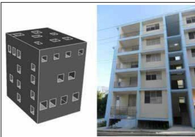
Fig. 2. Menor tersura se obtiene con balcones corridos.
