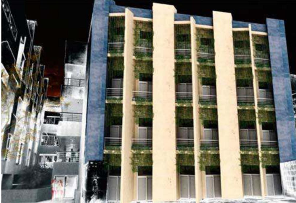
*Fig. 25. Vegetación como elemento de protección en la fachada suroeste del edificio 6.*
