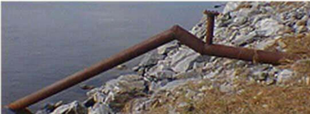
Fig. 3. Sifón autocebante en el embalse Las Casas 2.
