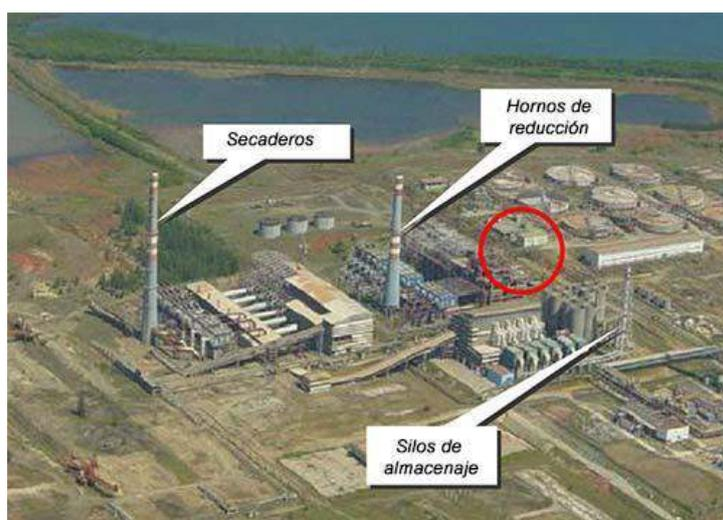
*Fig. 2. Vista de la planta actual, mostrando las chimeneas existentes.*
