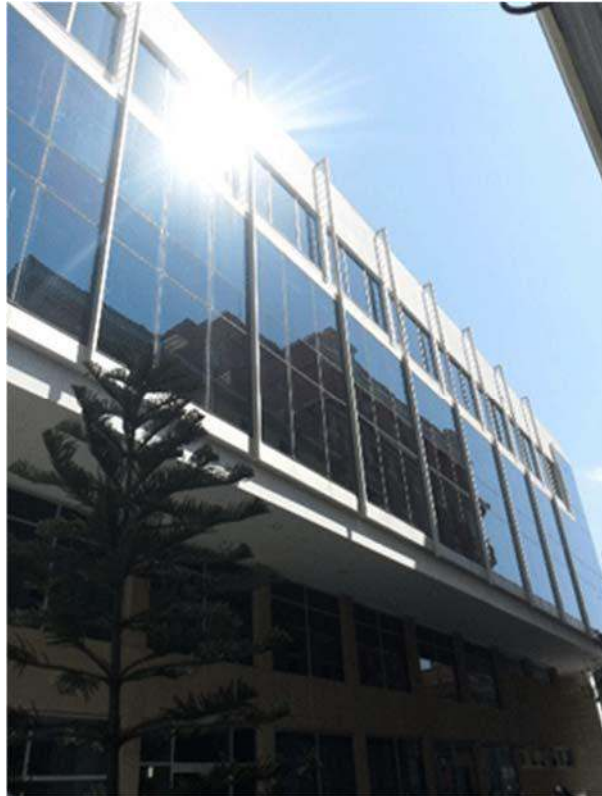
Fig. 10. Colegio de San Gerónimo en el Centro Histórico de La Habana. Fuente: Foto de la autora.
