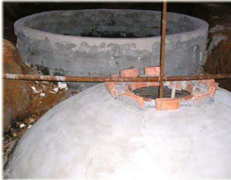
Fig. 1. Biodigestores de cúpula fija.
