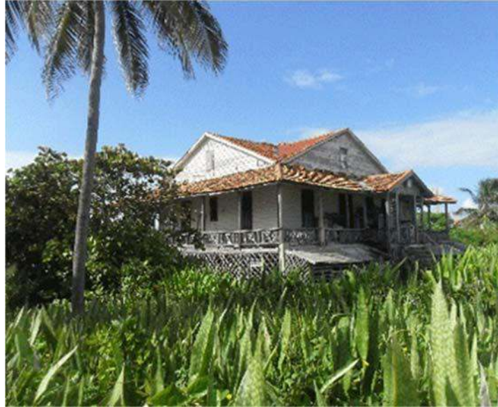
Fig. 8. Vivienda de madera en Varadero. Fuente: Foto de la autora
