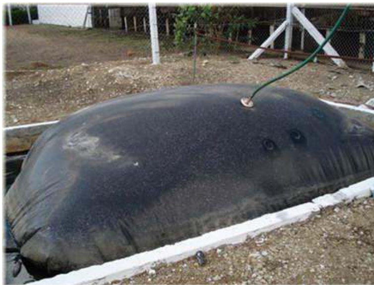
Fig. 2. Biodigestores tipo túneles.
