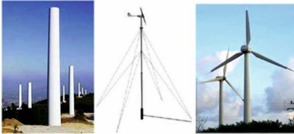
Fig. 1. (A la izquierda), estructuras tubulares autosoportadas, (al centro), tubular con riendas, (a la derecha) vista del parque eólico demostrativo de Turiguanó, Ciego de Ávila, Cuba.
