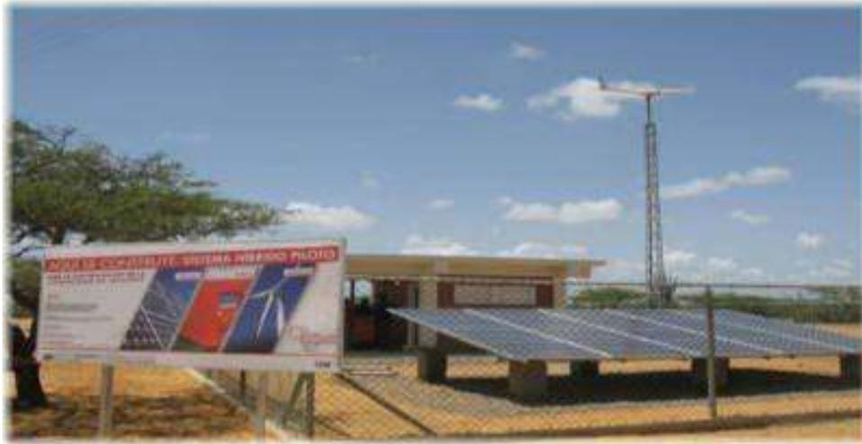
Fig. 34. Sistemas híbridos eólico-fotovoltaico-diésel.
