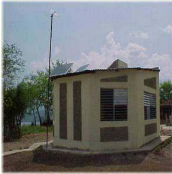
Fig. 14. Sala de televisión con sistema fotovoltaico autónomo.
