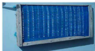
Fig. 6. Malla colocada para filtrar el aire que entra en el interior del aerogenerador.
