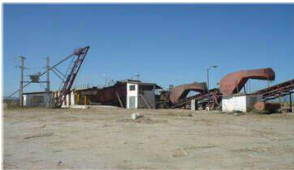
Fig. 2. Instalación de limpieza con tres expansores.
