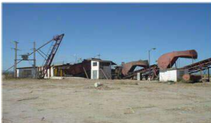
Fig. 1. Algunas instalaciones de interés en el estudio.
