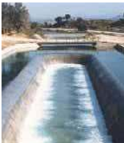
Fig. 4. Central hidroeléctrica en canal de riego.
