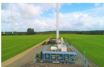
El fabricante de aerogeneradores germano-español ha desarrollado el primer proyecto del mundo capaz de producir hidrógeno verde directamente a partir del viento en "modo isla". Se trata de un aerogenerador que alimenta directamente a un electrolizador, que es la máquina que divide el agua en sus dos componentes: oxígeno e hidrógeno. El
