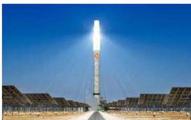
El uso de la energía solar térmica ha ganado espacios con la puesta en marcha de varias instalaciones, en las cuales un gran número de espejos móviles, llamados heliostatos, concentran los rayos solares hacia una torre central.
