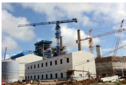
Bioeléctrica Ciro Redondo en construcción, provincia Ciego de Ávila (ACN)
