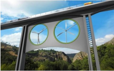
El viaducto del barranco El Juncal en Gran Canaria (España), ha servido de referencia a científicos españoles y británicos para comprobar que el viento que sopla entre los pilares de este tipo de infraestructuras puede mover aerogeneradores y producir energía.
