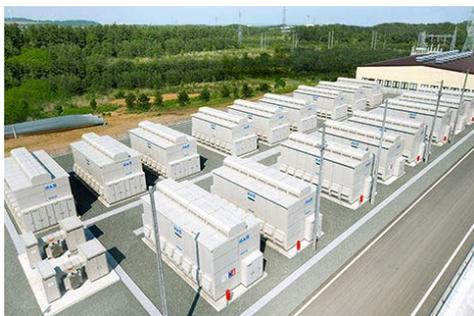
La instalación se proyecta con capacidad para 50 MW, ocupará 14 000 m<sup>2</sup> y estará integrada por baterías de sulfuro de sodio para abastecer 30 000 hogares. La firma japonesa *Mitsubishi Electric Corp* fue encargada por *Kyushu Electric Power* para suministrar un sistema de almacenamiento masivo con destino a la planta en la prefectura de Fukuoka.
