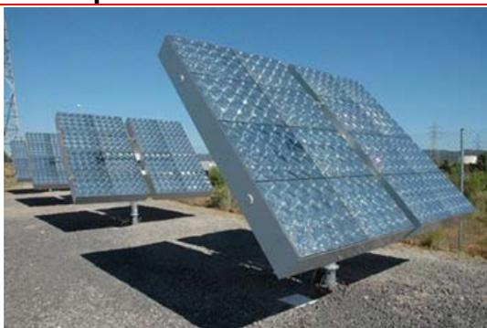
La empresa Valldoreix Greenpower, dedicada a las energías renovables y especializadas en CPV (Concentradores fotovoltaicos por sus siglas en inglés), ha creado CPVRS, un novedoso sistema de concentración fotovoltaica. Se trata de un sistema completamente integrado con una apertura solar de 7.2 m<sup>2</sup> que alcanza una potencia total de 2.16 kWp. El sistema alcanza una
