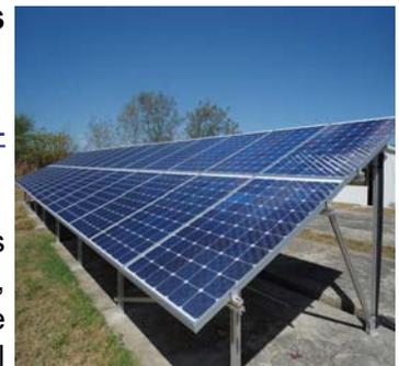
Los sistemas fotovoltaicos que se instalarán poseen una capacidad de dos mil watts (W), con una vida útil de cinco a ocho años, y admiten cargas inductivas, pues se pueden utilizar equipos electrodomésticos
