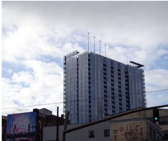
Generación distribuida con pequeños aerogeneradores instalados en un edificio en Portland, Oregon, EEUU.
