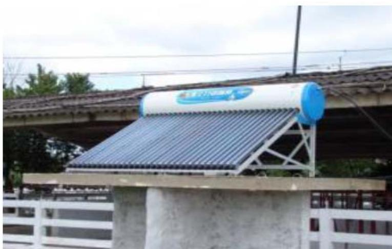
**Figura 2.** Calentamiento de agua utilizada para el lavado de filtros sanitarios y sistemas de ordeños empleando energía solar
