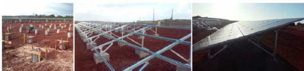
Figura 1 Fases de proceso ejecutivo de los parques solares fotovoltaicos
